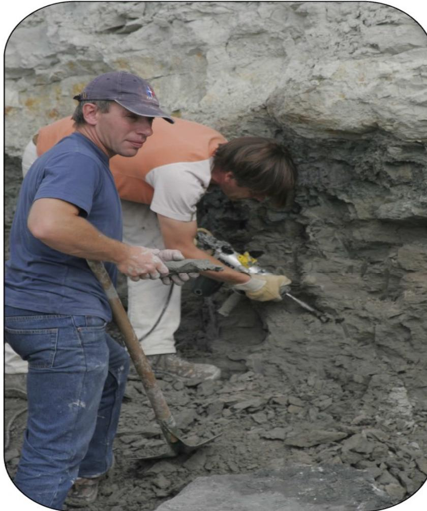
**Les marnes sont assez friables, et les blocs se dégagent aisément au marteau pneumatique.**
